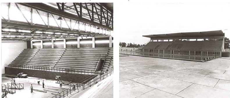
Figura 42 – Instalações construídas na década de 1970 – ginásio e piscina olímpica.
