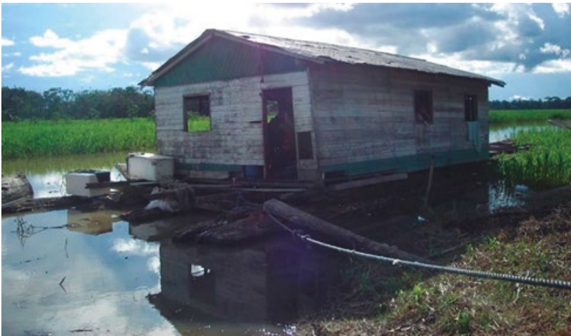
Figura 2 – Casa flutuante sobre boias de assacu muito encontrada na Reserva de Desenvolvimento Sustentável Mamirauá, Tefé, Amazonas, Brasil.
